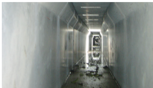
インバートコンクリート打設
