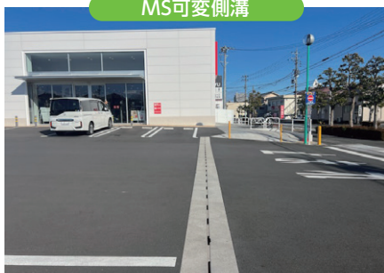
民間工事：藤枝市
