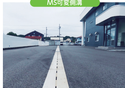
民間工事：掛川市
