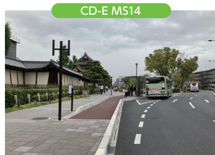
京都国道事務所：国道24号烏丸通 京都市
