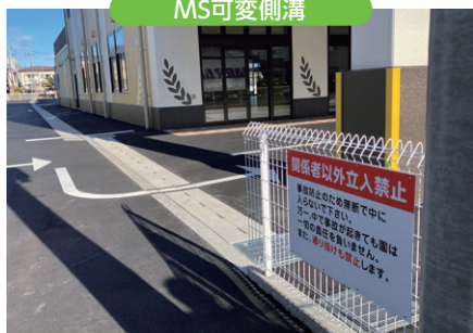
民間工事：静岡市
