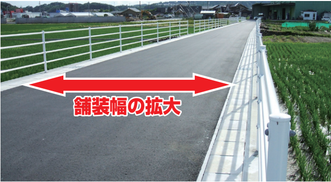
側溝の天端幅が狭いので、道路幅が広く使えます。
