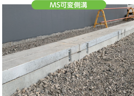
民間工事：豊明市
