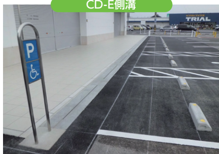
民間工事：津市
