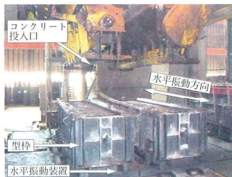
写真-1 フレッシュコンクリートの打設の一例
