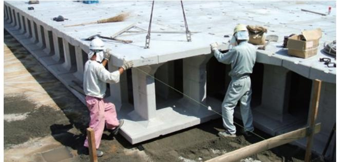
敷モルタルを用いて高さの調整を行いながら、本体製品を据え付けます。
