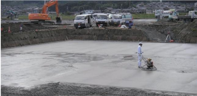
コンクリートの均し面を精度良く仕上げると、製品の据付が容易になります。
