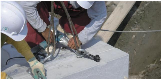
本体とパネル及びパネル同士を連結します。仮止めをするまでは吊金具を外さないようにしてください。
