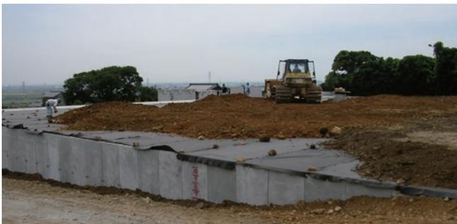
製品上面に吸出防止材を敷き、土を埋戻します。
