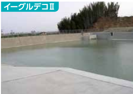
民間工事：朝日町
