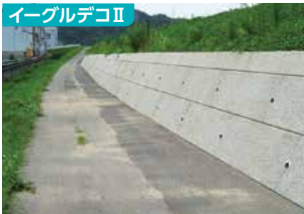
岐阜国道事務所：東海環状美濃 美濃市
