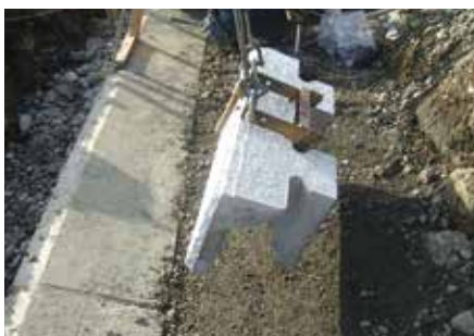
1 最下段据付(専用吊り金具にて)
