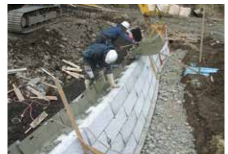
3 砕石転圧後、生コン打設
