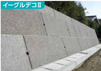
浜松市天竜総合事務所： 市道天竜曲り3号線 天竜市
