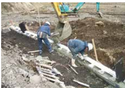
4 生コンが硬化前に、仕切り型枠を抜く ※(仕切り型枠を引き上げるタイミングに要注意)
