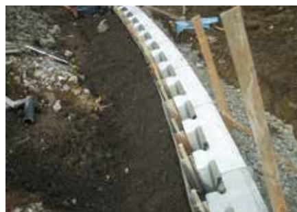
2 裏型枠設置後、砕石投入
