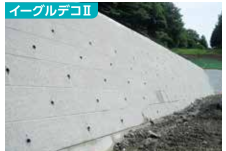
民間工事：掛川新病院 掛川市
