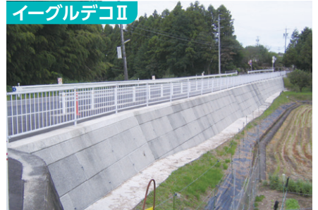
四日市建設事務所：四日市関線 四日市市
