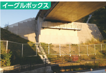
紀南河川国道事務所： 近畿自動車道紀勢線 田辺市
