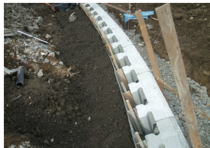
2 裏型枠設置後、砕石投入
