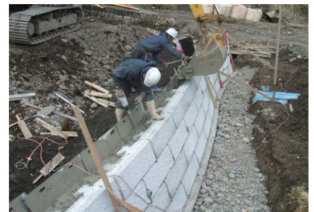
3 砕石転圧後、生コン打設
