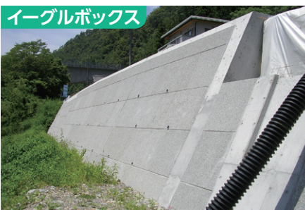
美濃土木事務所：一級河川長良川 美濃市
