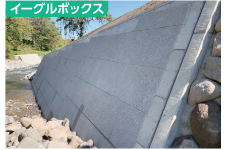
北信建設事務所：災害復旧 栄村
