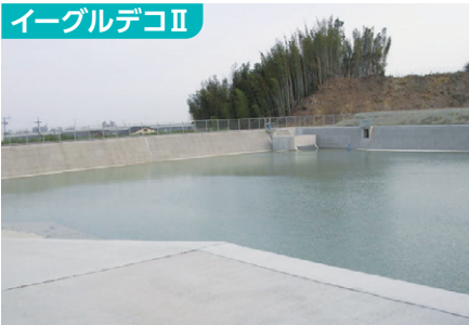
民間工事：朝日町
