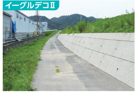
岐阜国道事務所：東海環状美濃 美濃市
