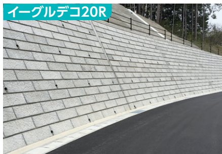
イーグルデコ20R 設案ダム工事事務所：町浦シウキ線 設楽町
