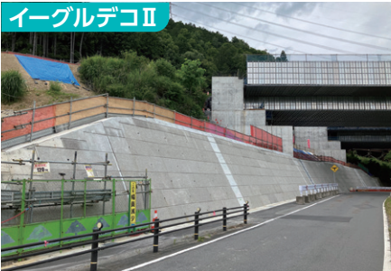
NEXCO西日本新名神京都事務所： 宇治田原トンネル 宇治田原町
