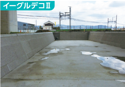
奈良国道事務所： 京奈和自動車道（大和御所道路）磯城郡川西町
