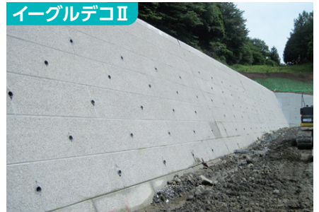
民間工事：掛川新病院 掛川市
