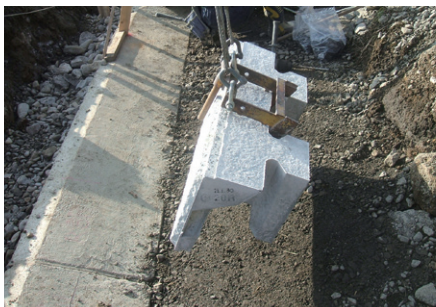
1 最下段据付(専用吊り金具にて)
