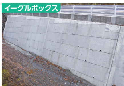
相武国道事務所：災害復旧 八王子市
