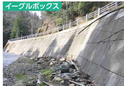
南丹土木事務所： 府道51号舞鶴和知線 京丹波町
