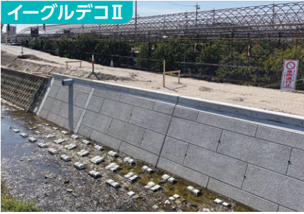
東三河建設事務所：災害復旧 豊川市
