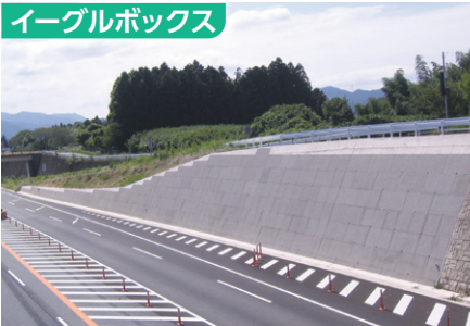
三重河川国道事務所：国道1号線 亀山市
