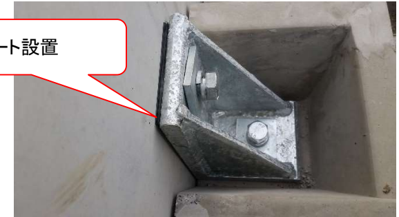
⑤底版側ボルト増し締め
