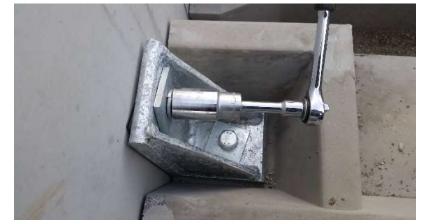
⑥側溝本体側ボルト増し締め
