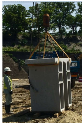
補巻フックのスリングベルトで製品をバスケット吊りにする。 主巻フックの吊り金具を吊り穴に入れロックする。
