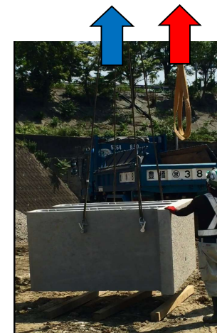
補巻フックを巻き上げ、吊りマスターのロックを再確認し、主巻フックで据付を行う。
