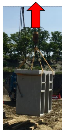
補巻フックを使用し、地面から50cm程度吊り上げる。
