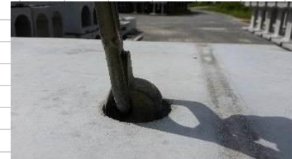
③ ストッパーを吊り上げ方向に倒す。
