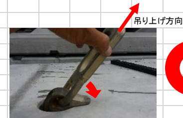
③ ストッパーを吊り上げ方向に倒す。
