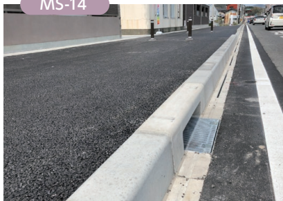
京都国道事務所：国道9号亀岡地区 亀岡市
