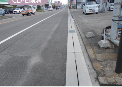
知多建設事務所：一般国道247号 半田市
