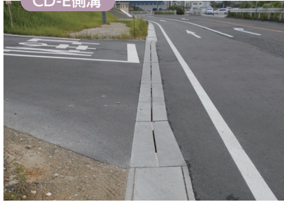
尾張建設事務所：瀬戸大府東海線 瀬戸市
