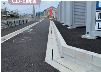
豊田市役所：寺部土地区画整理
