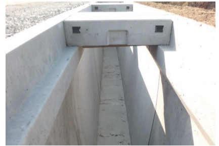
インバートコンクリート打設
