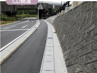
袋井土木事務所：吉沢金谷線 菊川市
