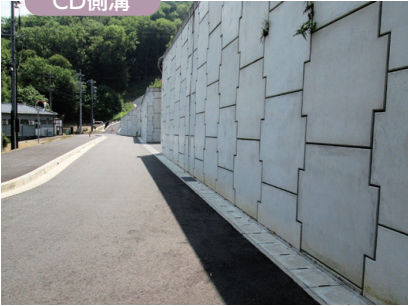
岐阜国道事務所：国道156号 岐阜市
