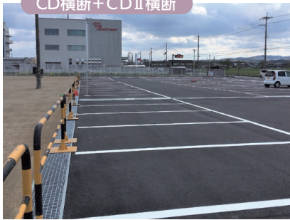
城陽市役所：城陽消防署本部駐車場
