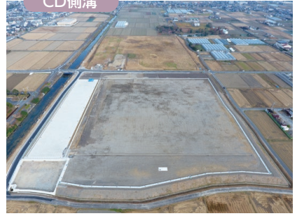
北方町：北方工業団地
