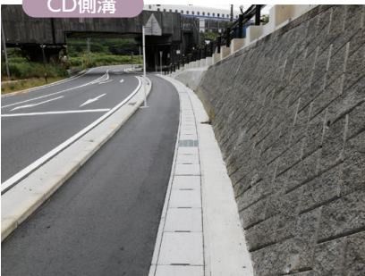
袋井土木事務所：吉沢金谷線 菊川市
