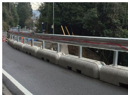
大垣事務所：災害復旧工事
