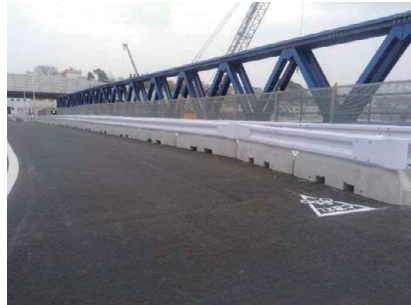
NEXCO中日本：東京外かく環状道路 東名Hランプ
