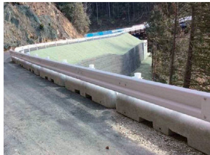
設案ダム工事事務所：設案ダム工用道路整備工事
