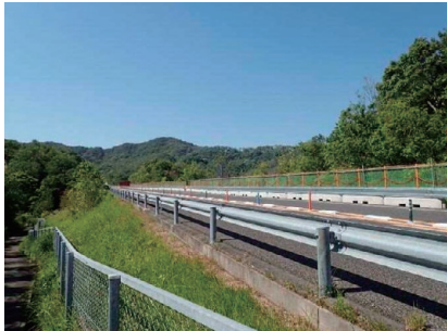
NEXCO西日本：阪和自動車道尻掛橋下部工
