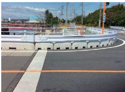
愛知県衣浦港務所：衣浦港改修工事（重要）迂回路工
