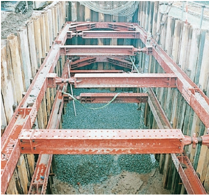
④耐圧底版 コンクリート工
