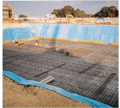
⑥端面部材 据付組立工
