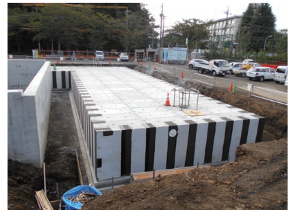
民間工事：横浜市
