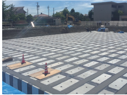
安城市役所：二本木小学校
