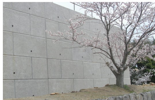
民間工事：西尾市
