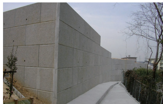
民間工事：東海市
