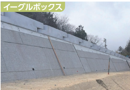
滋賀県土地開発公社： 国道477号道路拡幅 竜王町
