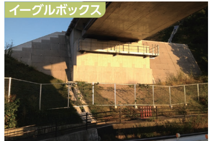
紀南河川国道事務所：近畿自動車道紀勢線 田辺市
