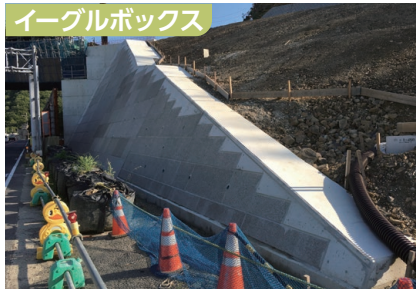
浪速国道事務所：第二阪和国道 岬町
