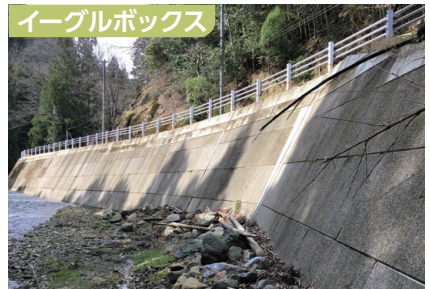
南丹土木事務所：府道51号舞鶴和知線 京丹波町
