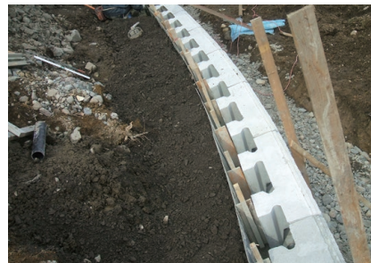
2 裏型枠設置後、碎石投入
