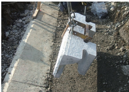
1 最下段据付(専用吊り金具にて)
