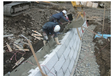
3 碎石転圧後、生コン打設
