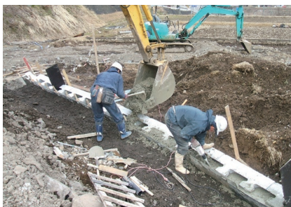
4 生コンが硬化前に、仕切り型枠を抜く ※(仕切り型枠を引き上げるタイミングに要注意)
