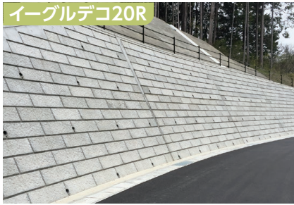
イーグルデコ20R 設楽ダム工事事務所：町浦シウキ線 設楽町
