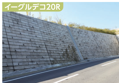
イーグルデコ20R 和歌山河川国道事務所： 京奈和自動車道(橋本道路)側道 橋本市
