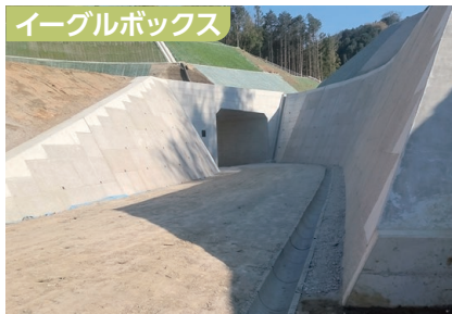
沼津河川国道事務所：天城北道路 伊豆市
