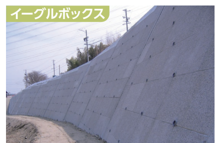
イーグルボックス 桑名建設事務所：二級河川砂出川 桑名市
