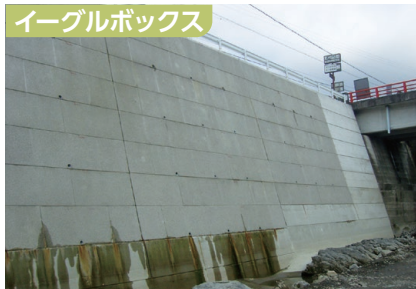
吉野土木事務所： 主要地方道高野天川線 天川村
