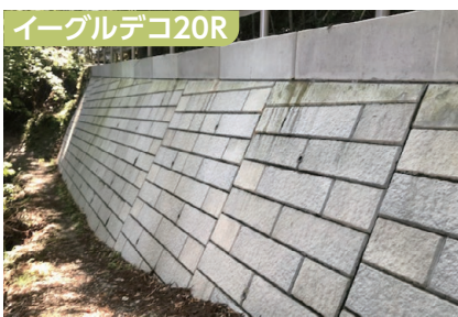
イーグルデコ20R 浜松市役所：天竜相津線線道路災害復旧工事
