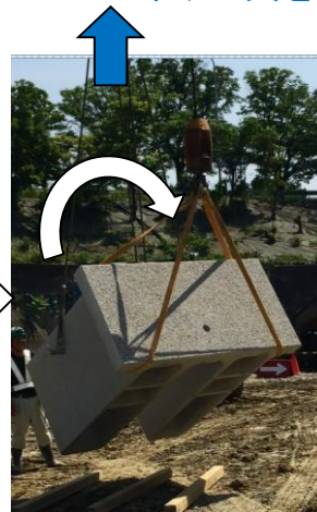
主巻フックを製品が水平になるまで吊り上げ、反転する。
