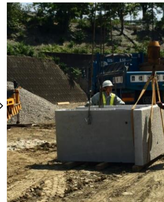
主巻フックと補巻フックを同時に降ろし、一旦仮置きし、スリングベルトを製品から外す。
